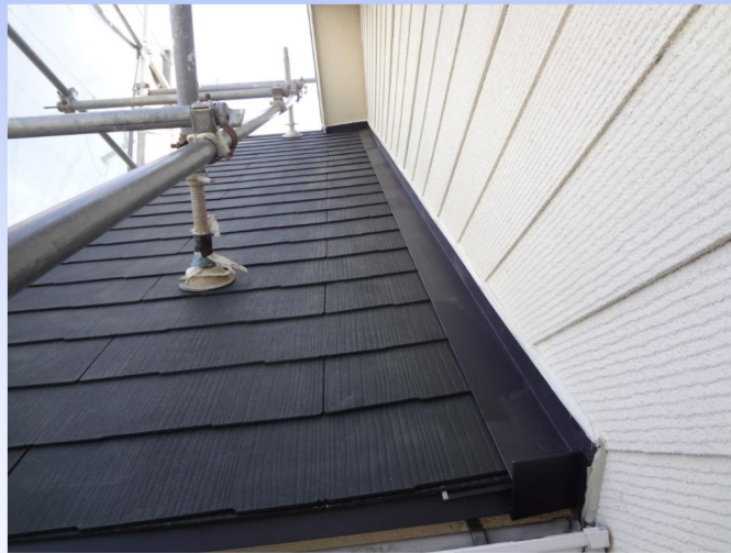
棟違い張り終わり
