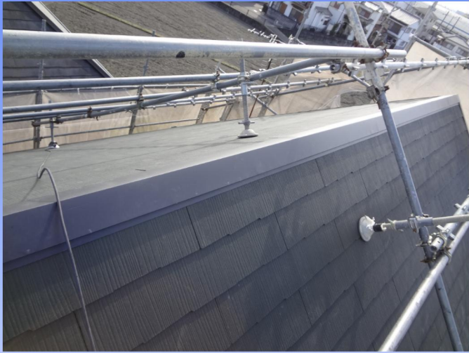
棟トタン張り終わり
